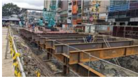
Gambar 4.6 Pemasangan Pendukung dan Balok Utama (Sumber: Dokumentasi Penulis)
