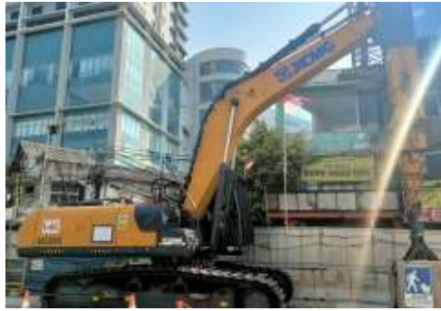
Gambar 3.34 XCMG Excavator Teledipper (Sumber: Dokumentasi Penulis)
