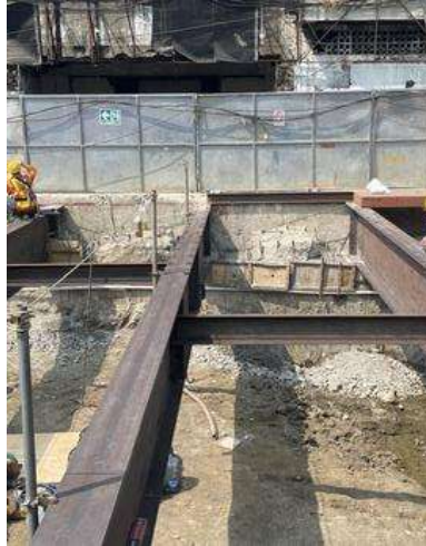
Gambar 3.28 Beam Support (Sumber: Dokumentasi Penulis)
