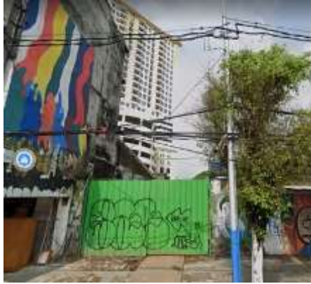
Gambar 3.3 View Existing Entrance 1 (Sumber: Dokumentasi PT. Hutama Karya)
