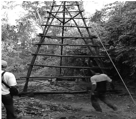
Gambar 3.7. Pengeboran Sumur Eksplorasi
