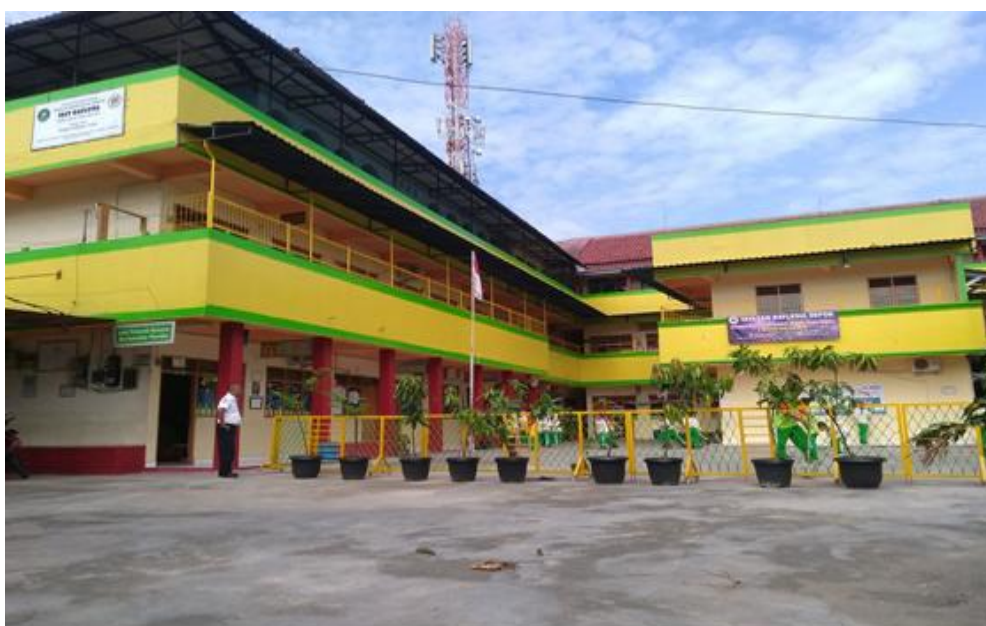
Gambar 2. Bangunan sekolah SDIT Raflesia Depok
