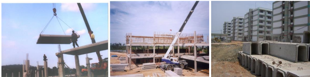
Gambar 2.5. Sistem Pracetak untuk Rumah Susun di Indonesia
