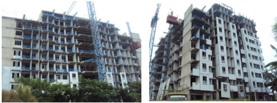
Gambar 2.7. Konstruksi Rusunawa Rempoa (Kolom, Balok dan Pelat )
