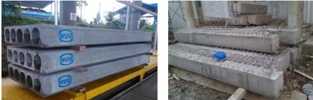
Gambar 4.13. Hollowcore dan Balok Precast
