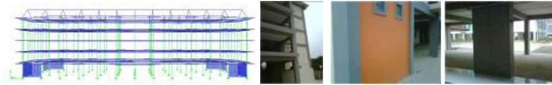
Gambar 10c Blok 5 (2009) dengan dinding geser di lantai dasar : tidak ada kerusakan
