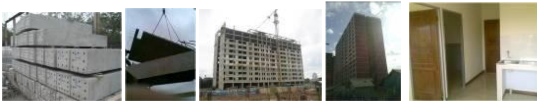
Gambar 11 Rumah Susun Sederhana Bertingkat Tinggi dengan Sistem Pracetak di Jakarta
