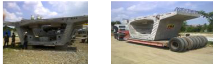
Gambar 13 Segmen standar sisi depan dan sisi belakang
