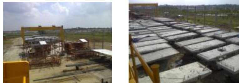
Gambar 5 Prinsip reuse : 6 set cetakan untuk menghasilkan 1000 komponen
