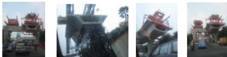
Gambar 18 Alat lifter dan pergerakannya dalam proses pemasangan
