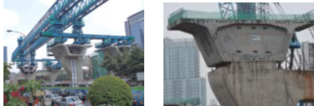
Gambar 2b Alternatif pier 2 kaki balok penghubung
