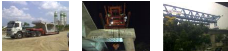
Gambar 17 Alat transportasi low bed dan alat pemasang lifter dan launcher
