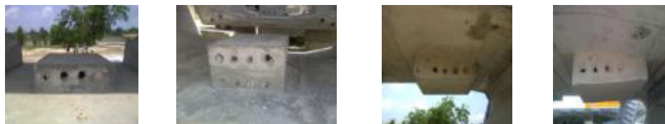
Tendon tengah atas dan bawah, untuk stressing sementara
