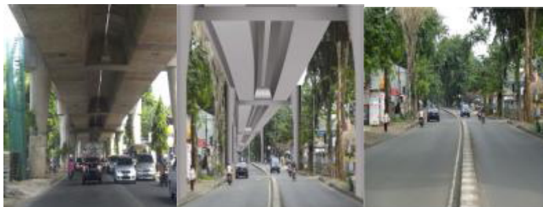
Gambar 8 Jalan Antasari : sebelum konstruksi, impresi artistik, setelah konstruksi.
