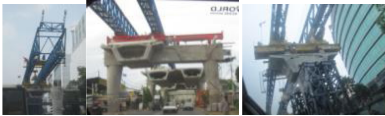
Gambar 20 Proses pemasangan segmen box dengan alat launcher
