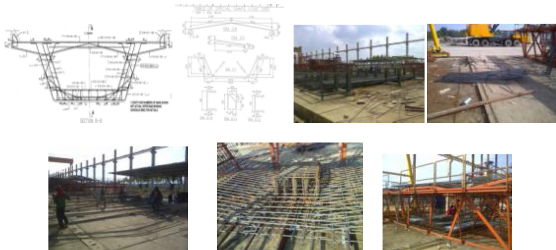
Gambar 4 Zero waste pada pembesian
