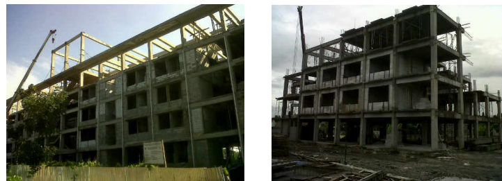
Gambar 6 Sistem pracetak sebagian
