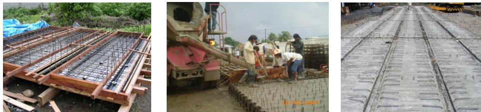
(b) Pengecoran di cetakan di permukaan tanah yang hampir tidak ada beton terbuang
