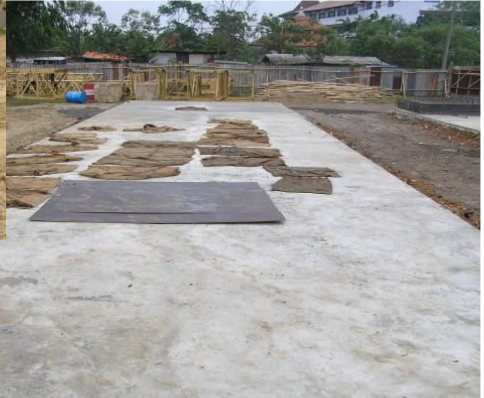
Pemasangan landasan cetakan
