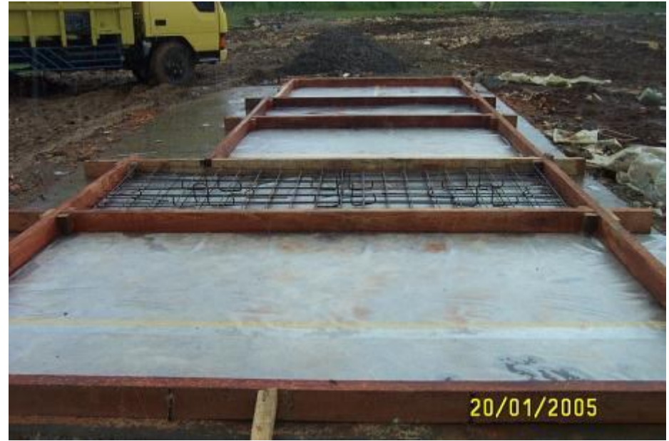
Setting dinding cetakan
