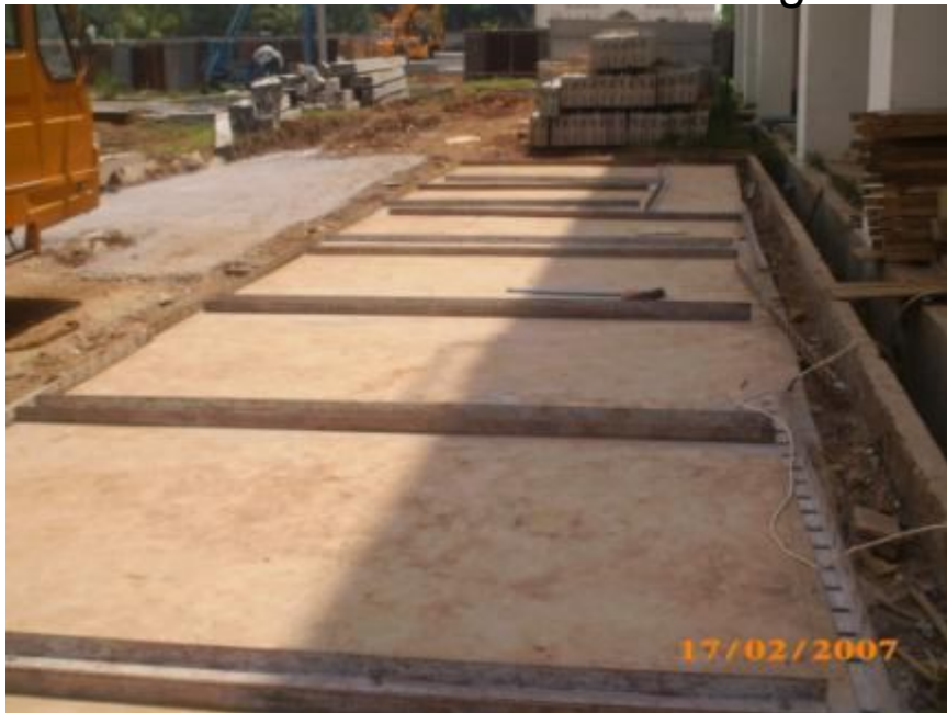
Setting dinding cetakan
