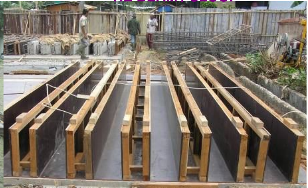
BALOK/KOLOM BAJA PENYIAPAN CETAKAN
