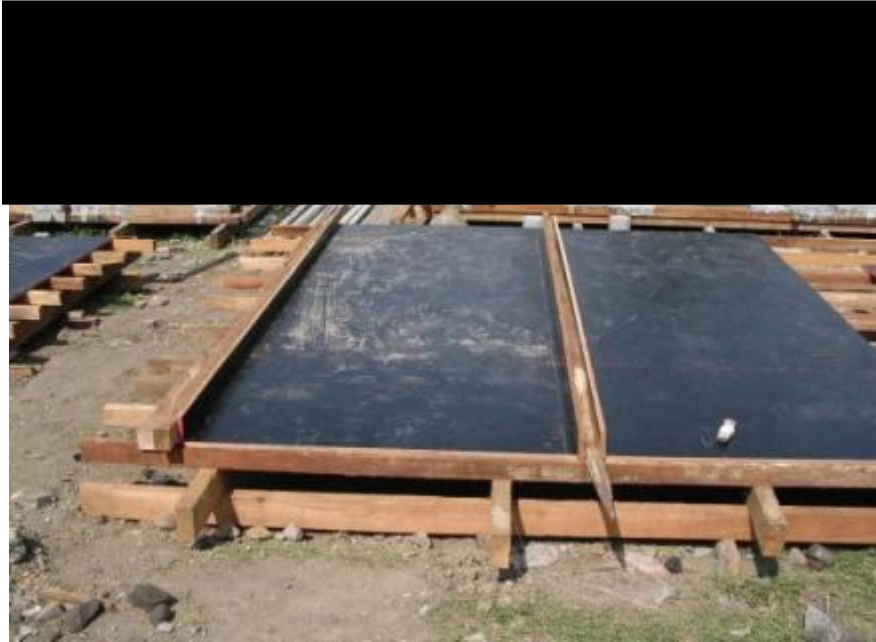
Setting dinding cetakan
