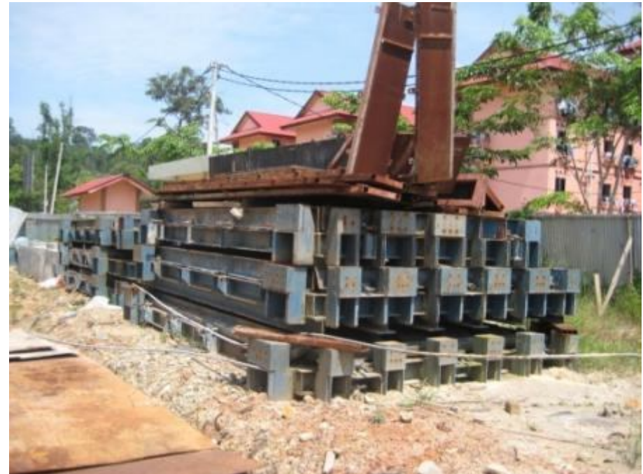
Cetakan pelat column slab dari bahan baja
