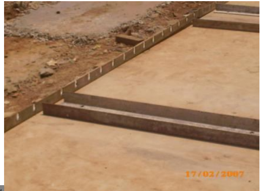
Setting dinding cetakan
