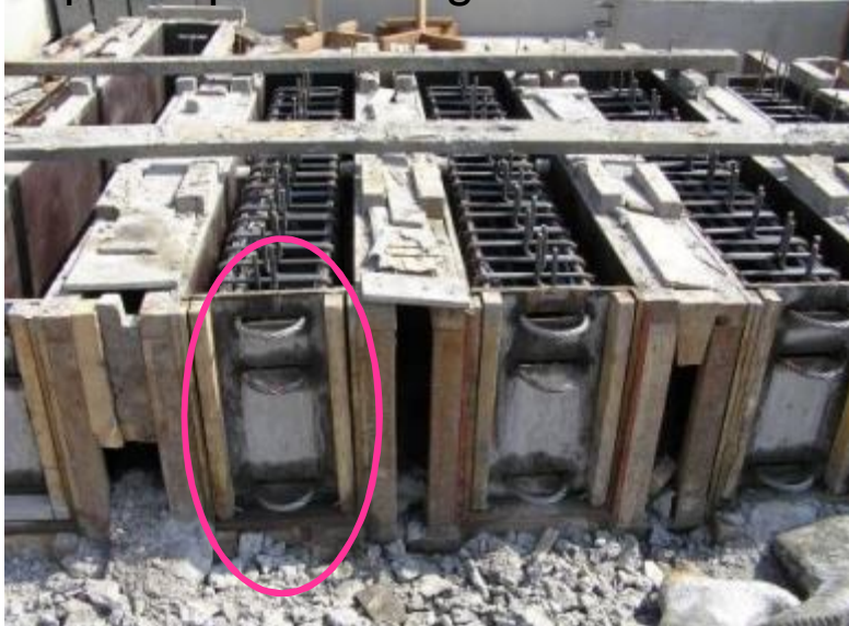
Pemasangan angkur sambungan
