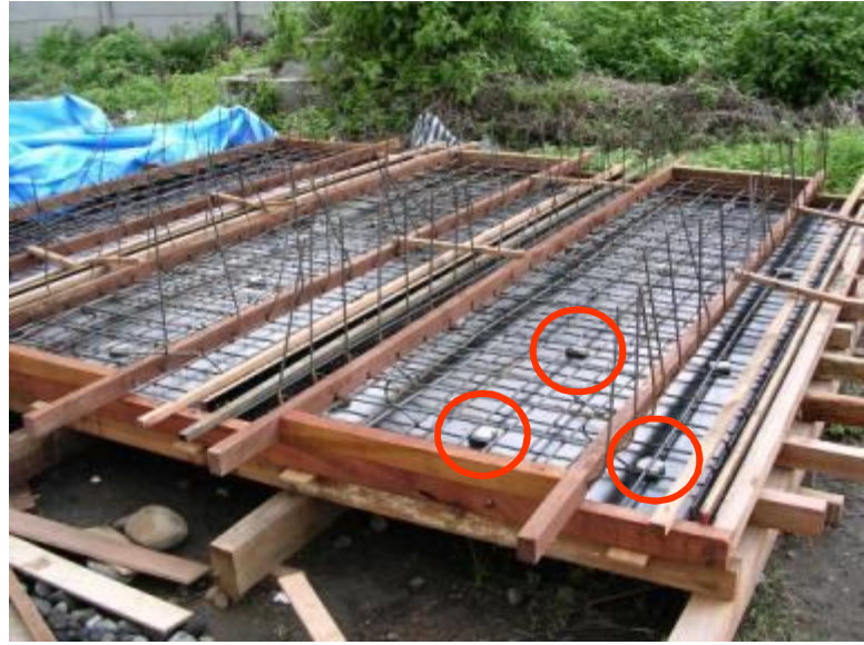
Pemasangan tulangan, dan cek ketepatan posisi dengan beton deking
