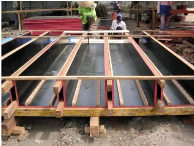
BALOK/KOLOM BAJA PENYIAPAN CETAKAN
