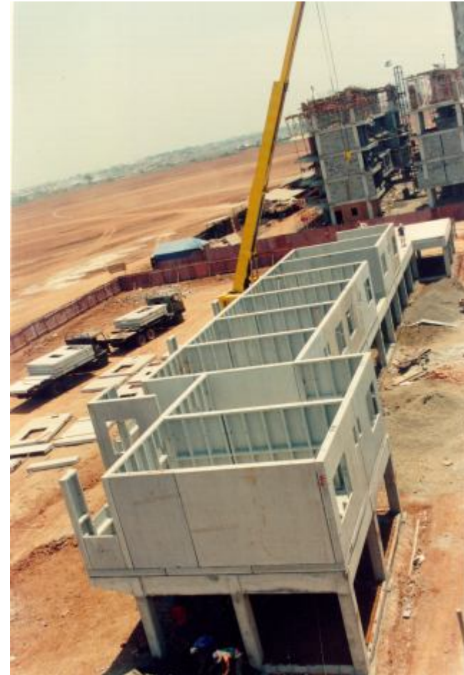
Sistem Dinding Penumpu
