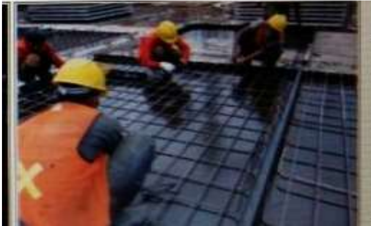
R/C slab, fabrikasi di lapangan,
