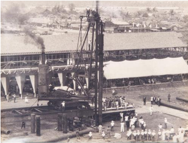
Tiang Pancang Pracetak pada Gedung Sarinah 1962
