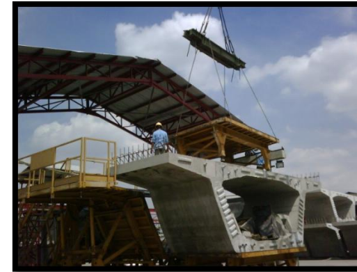
Sistem produksi Match Cast
