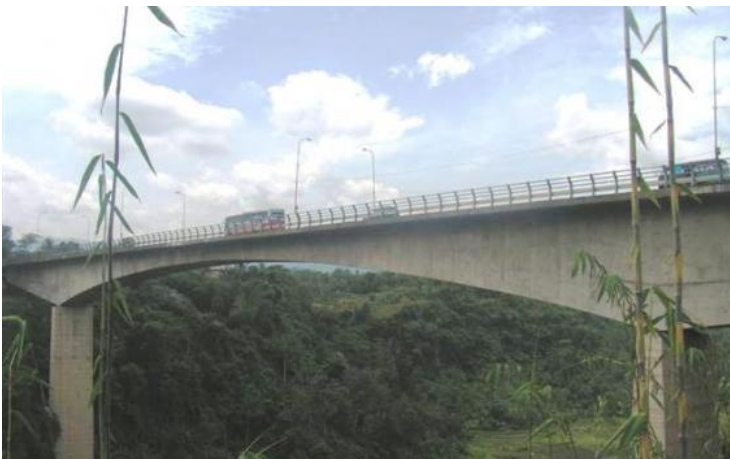
Struktur Prategang Metoda Kantilever pada Jembatan Rajamandala 1979
