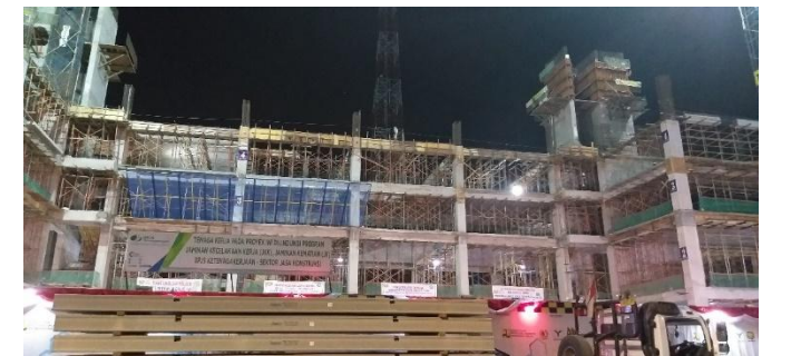
Kolom Konvensional, sambungan paskatarik tanpa lekatan + segmental
