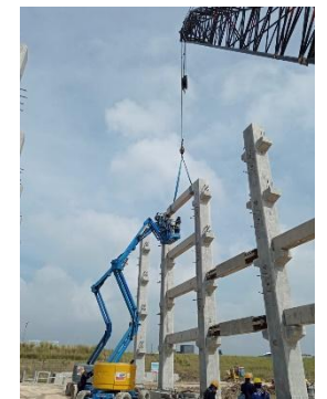
Kolom Tinggi, Balok, Hollow core, Sambungan Paskatarik tanpa lekatan, sambungan momen, sambungan pin
