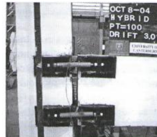
Kerusakan di alat pendisipasi energi, mudah diganti
