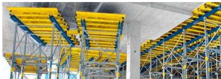
Sistem Perancah Bekisting
