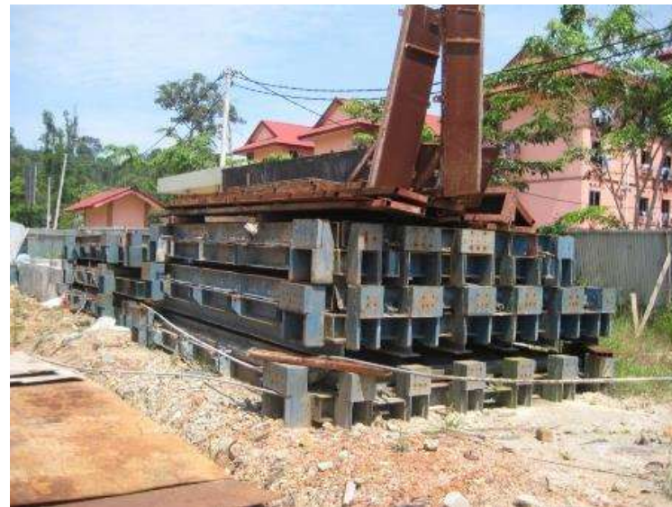
Cetakan pelat column slab dari bahan baja
