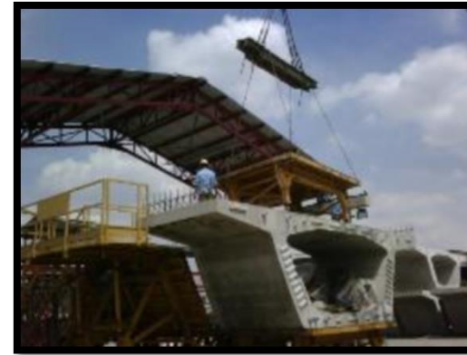
Sistem produksi Match Cast
