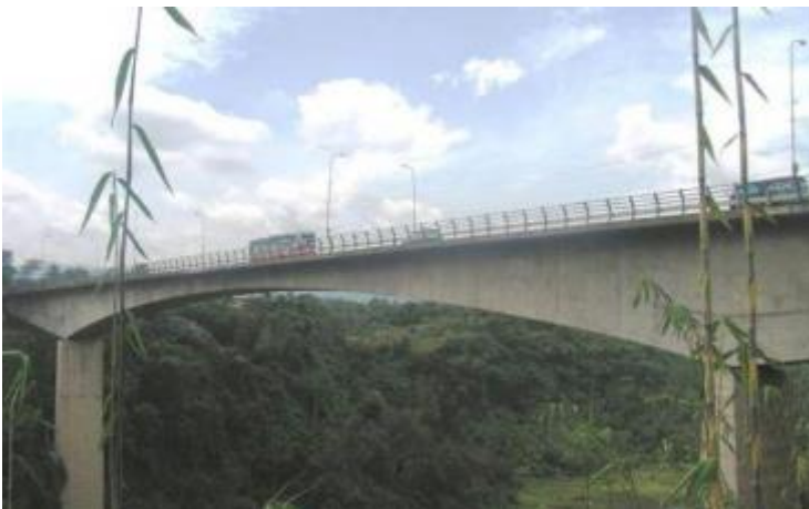
Struktur Prategang Metoda Kantilever pada Jembatan Rajamandala 1979
