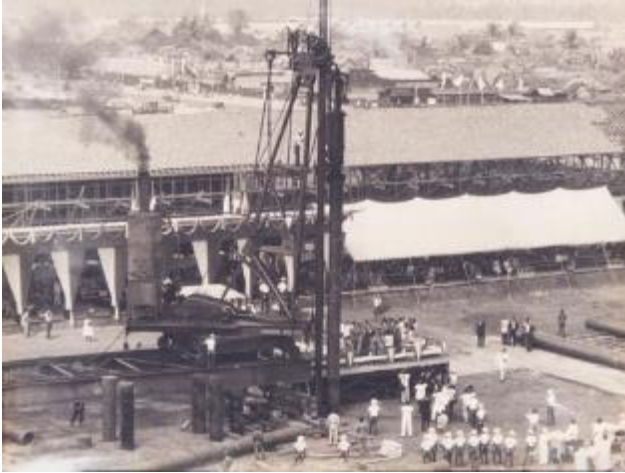
Tiang Pancang Pracetak pada Gedung Sarinah 1962
