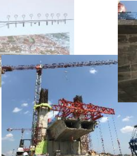
Pemasangan SHMS mulai dari tahap konstruksi pada Jembatan Musi IV dengan Sistem Extradoses (Gabungan Sistem Cable Stayed & Box Girder)
