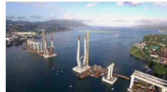
Merah Putih Bridge, Ambon (2015)
