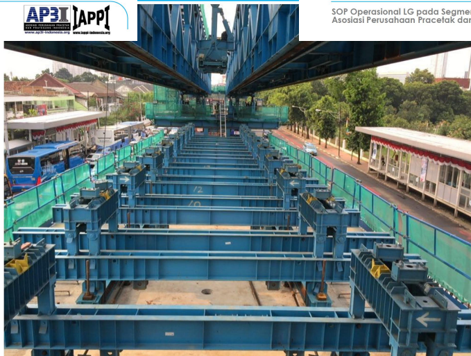
SOP Operasional LG pada Segmental Box Girder, Asosiasi Perusahaan Pracetak dan Prategang Indonesia.
