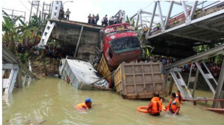
Pelugas mengevakuasi truk di lokasi jembatan Widang yang runtuh, Tuban, Jawa Timur, Selasa (17/4).
