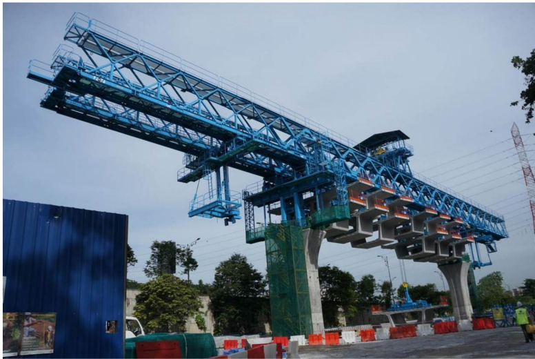
SOP Operasional LG pada Segmental Box Girder, Asosiasi Perusahaan Pracetak dan Prategang Indonesia.
