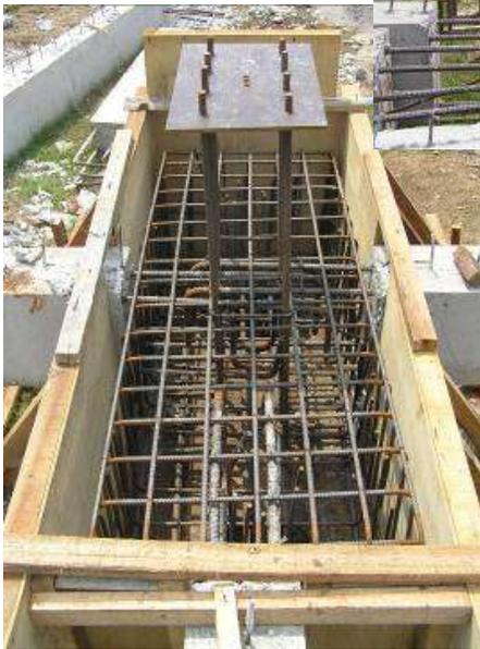
Pekerjaan struktur bawah penting yang terkait dengan sistem pracetak adalah membuat angkur untuk kolom lantai dasar
