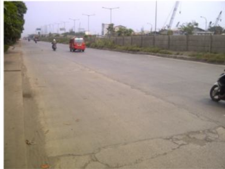
Ada retakan melintang di batas pengecoran
