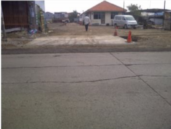
Ada retakan melintang di batas pengecoran
