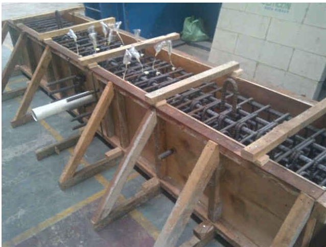
Perakitan tulangan dalam bekisting
