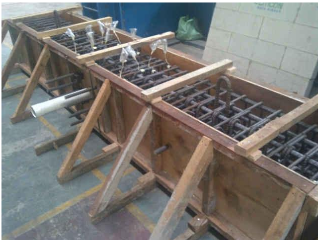
Perakitan tulangan dalam bekisting
