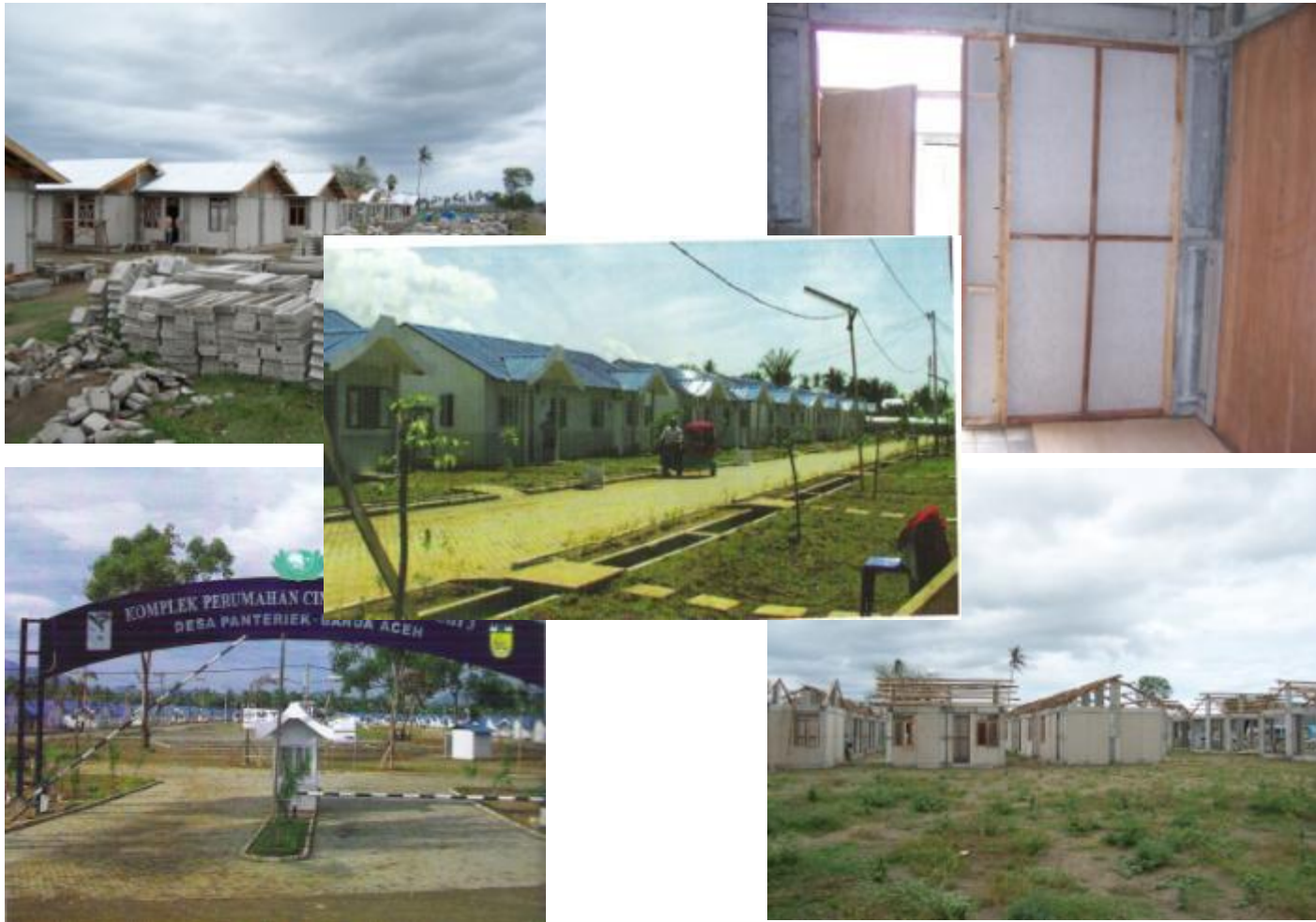
Pembangunan RSH Pracetak di Aceh
