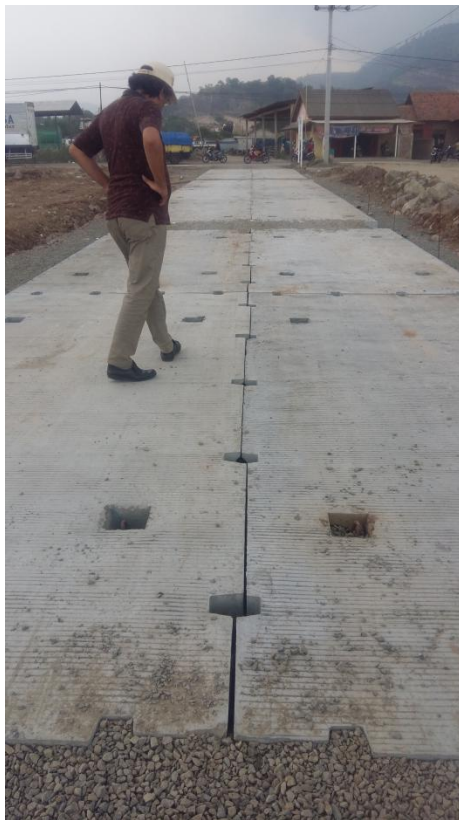
Jalan Pracetak di Banjarnegara
