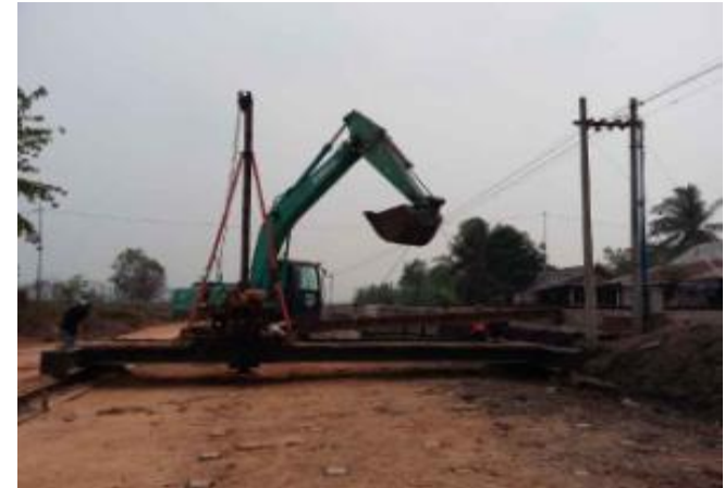
Pemasangan alat ATRA
