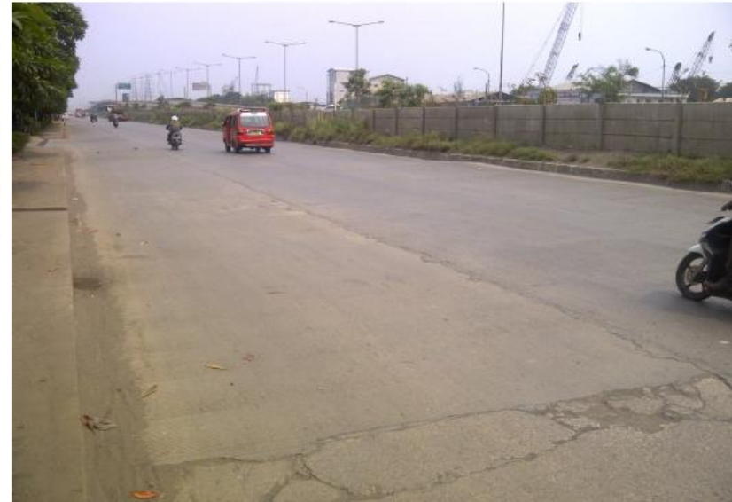
Ada retakan melintang di batas pengecoran
