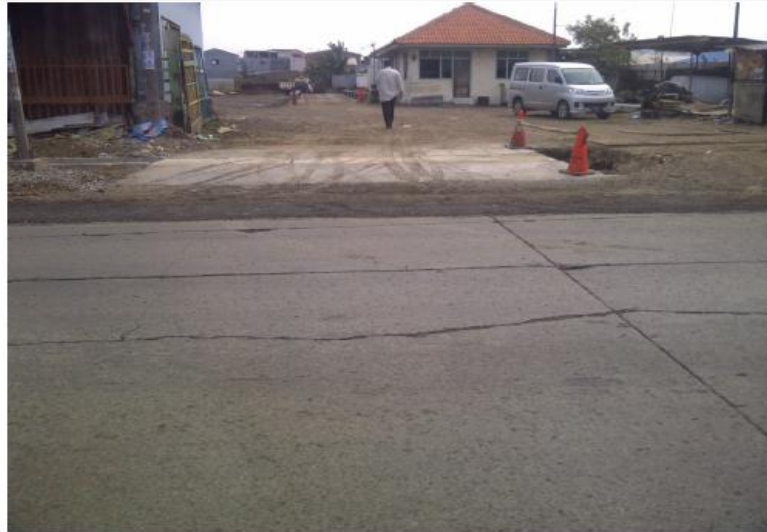
Ada retakan melintang di batas pengecoran
