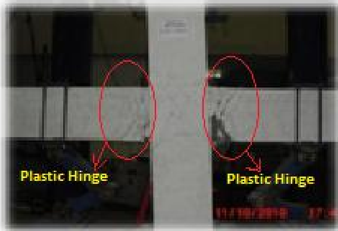
Kerusakan di balok (sulit diperbaiki)
