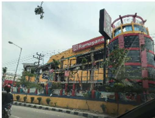
Bangunan Gedung Rubuh
