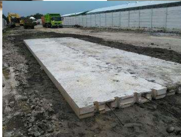
Jalan Pracetak di Cirebon Jawa Barat dan Klaten Jawa Tengah
