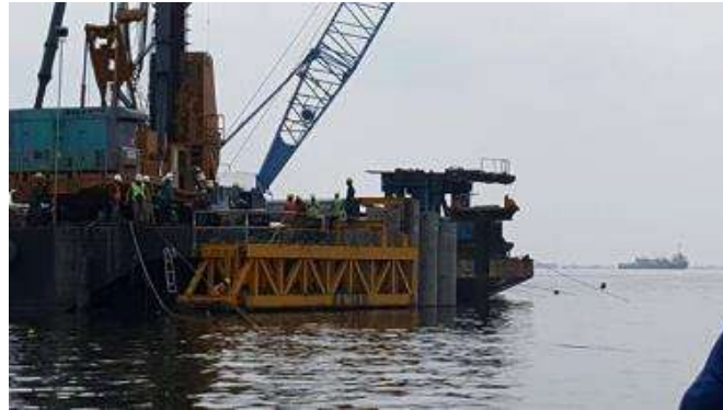
Inner boring dan Tiang Pancang Besar untuk Jakarta Giant Sea Wall
