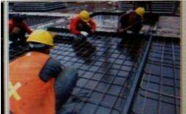
R/C slab, fabrikasi di lapangan,
