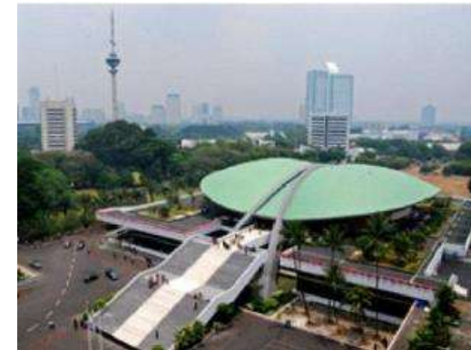
Struktur Prategang pada Gedung Parlemen 1965
