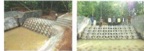
Bendung di Majalengka Jawa Barat dan Rip Rap di Balikpapan Kalimantan Timur
