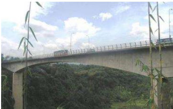
Struktur Prategang Metoda Kantilever pada Jembatan Rajamandala 1979
