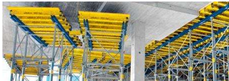
Sistem Perancah Bekisting
