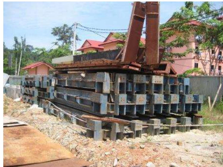
Cetakan pelat column slab dari bahan baja
