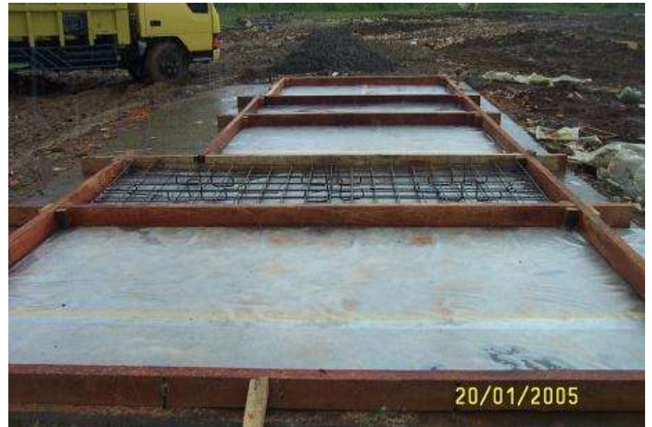
Setting dinding cetakan
