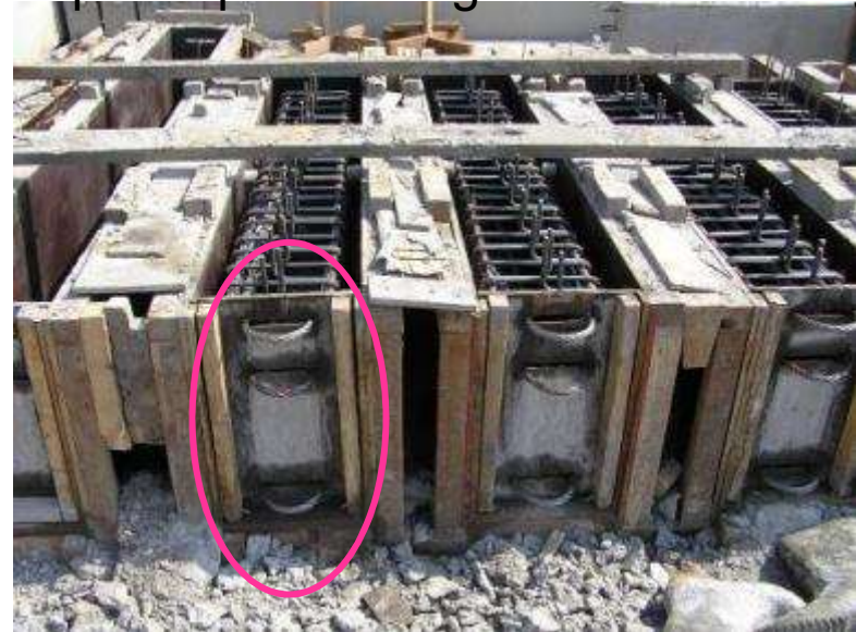
Pemasangan angkur sambungan
