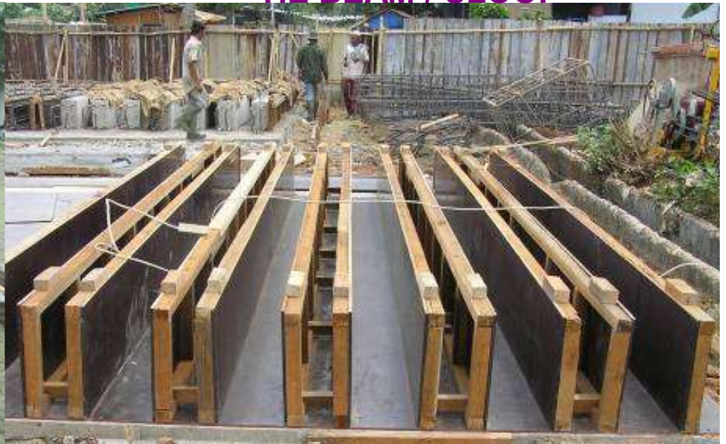
BALOK/KOLOM BAJA PENYIAPAN CETAKAN
