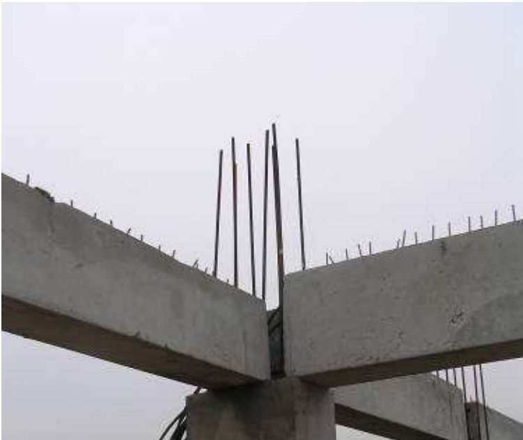
Pemasangan angkur join
