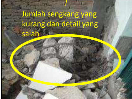
Detail konstruksi yang salah
