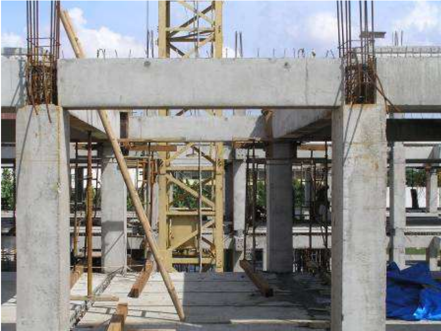
Pemasangan angkur join
