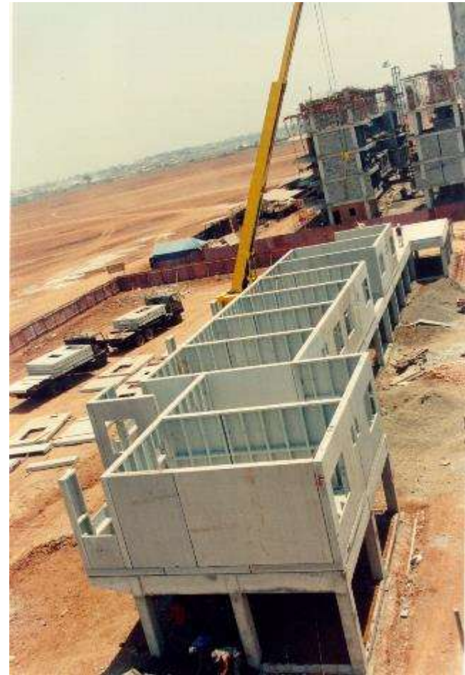
Sistem Dinding Penumpu
