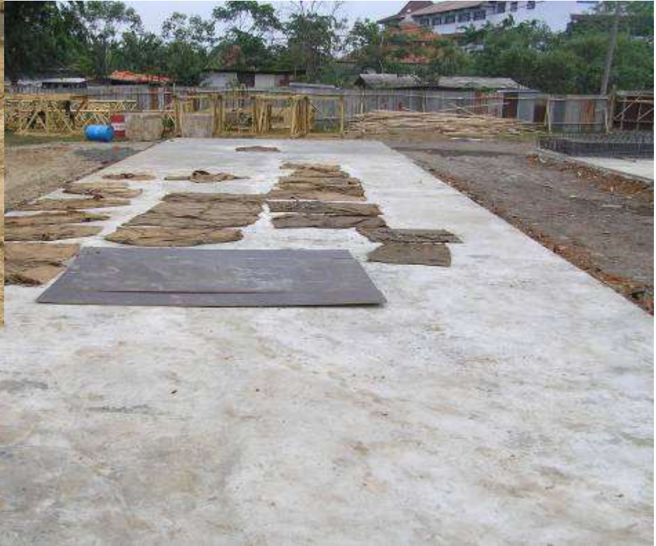
Pemasangan landasan cetakan
