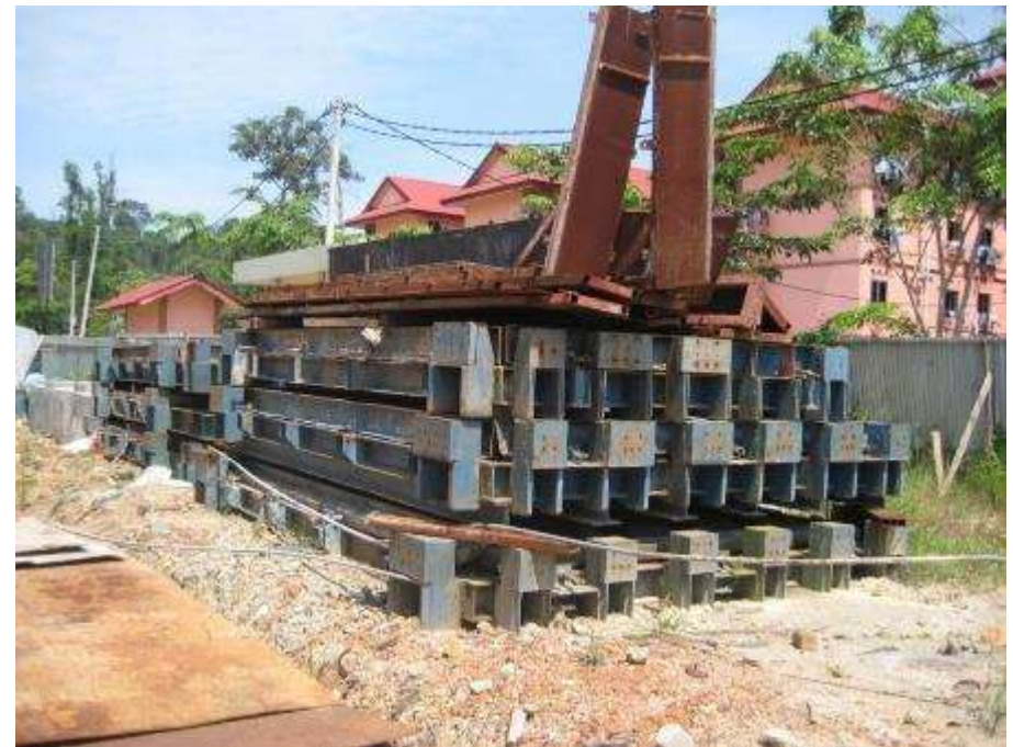
Cetakan pelat column slab dari bahan baja
