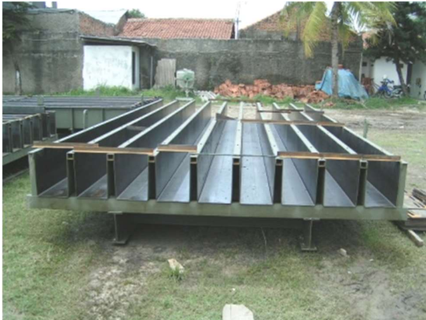
BALOK/KOLOM BAJA PENYIAPAN CETAKAN
