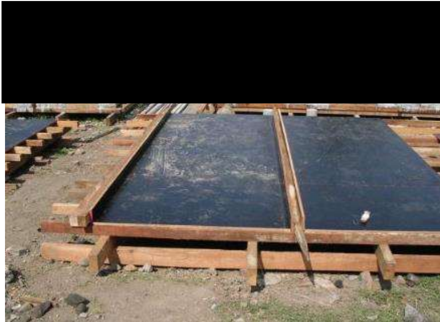
Setting dinding cetakan
