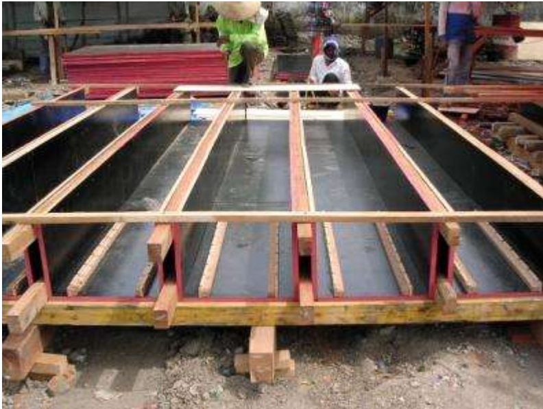
BALOK/KOLOM BAJA PENYIAPAN CETAKAN
