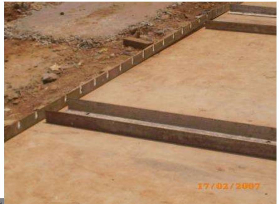
Setting dinding cetakan
