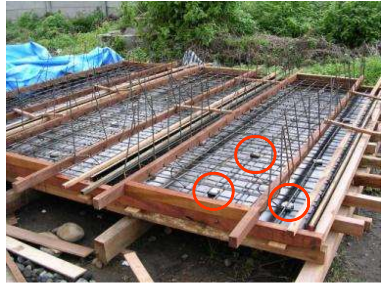
Pemasangan tulangan, dan cek ketepatan posisi dengan beton dekinng
