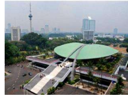
Struktur Prategang pada Gedung Parlemen 1965
