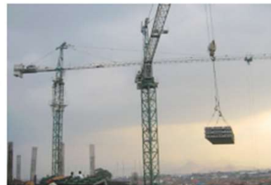
Pemasangan dengan tower crane, mobile crane dan hoist
