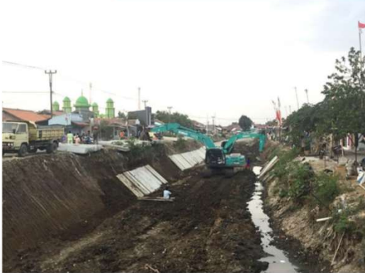
Gambar Pemasangan Panel DI. Pemali-Brebes
