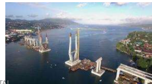
Merah Putih Bridge, Ambon (2015)
