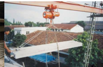
Pemasangan dengan tower crane, mobile crane dan hoist
