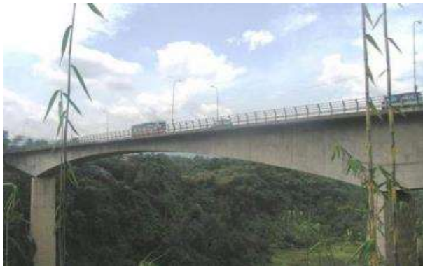
Struktur Prategang Metoda Kantilever pada Jembatan Rajamandala 1979
