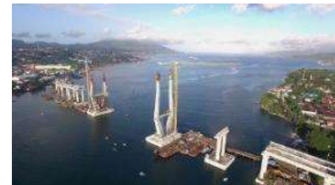
Merah Putih Bridge, Ambon (2015)
