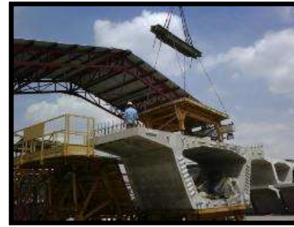
Sistem produksi Match Cast
