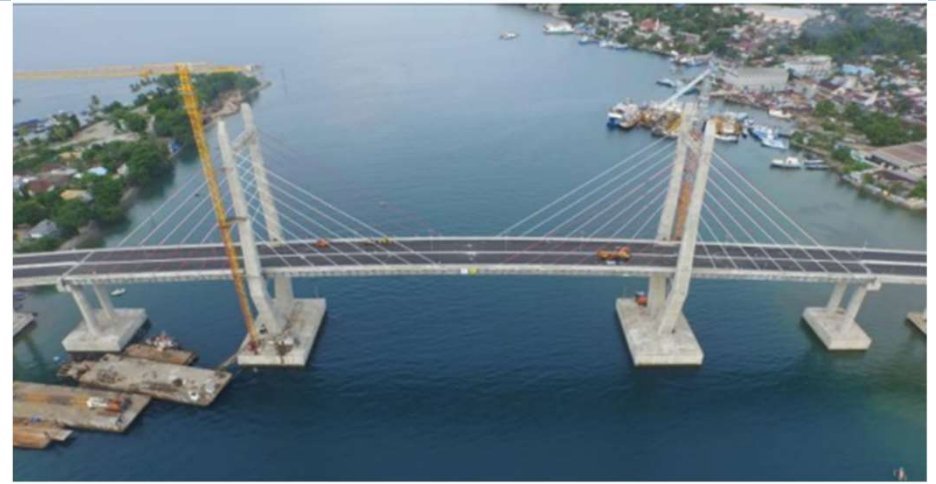
Jembatan Merah Putih Ambon
