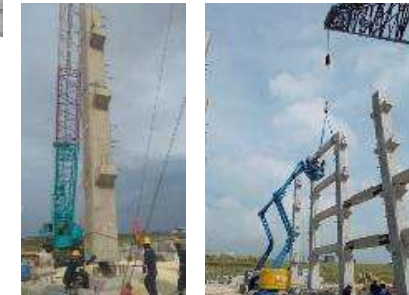
Kolom Tinggi, Balok, Hollow core, Sambungan Paskatarik tanpa lekatan, sambungan momen, sambungan pin
