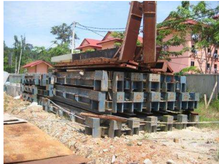
Cetakan pelat column slab dari bahan baja
