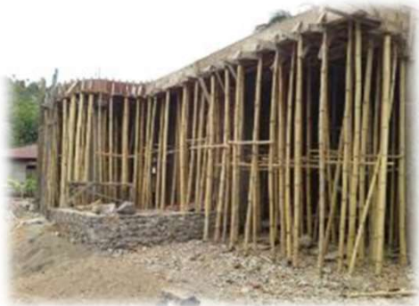
Perancah + Bekisting Kayu
