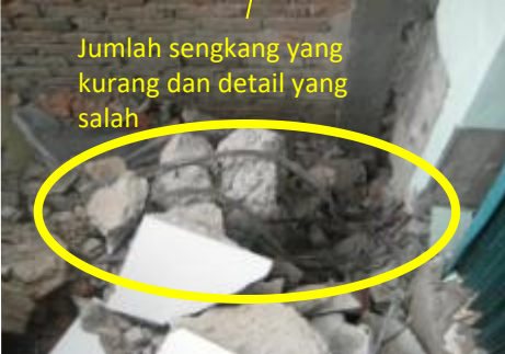
Detail hubungan kolom-pondasi yang salah
