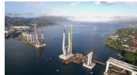
Merah Putih Bridge, Ambon (2015)
