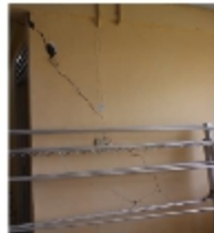
Retak dinding Lt.2 sampai tembus dalam kamar bangunan
