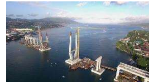
Merah Putih Bridge, Ambon (2015)
