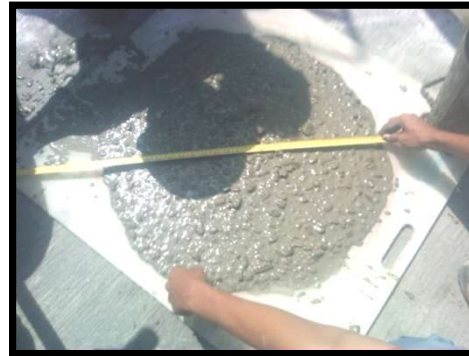
Beton kinerja tinggi
