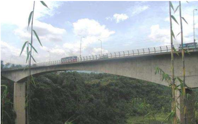
Struktur Prategang Metoda Kantilever pada Jembatan Rajamandala 1979
