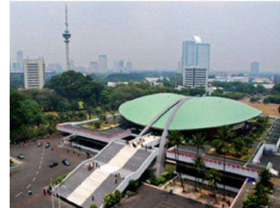
Struktur Prategang pada Gedung Parlemen 1965
