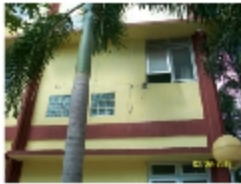
Retak dinding luar bagian depan dan samping bangunan
