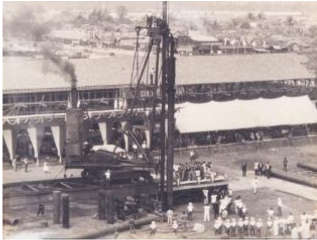
Tiang Pancang Pracetak pada Gedung Sarinah 1962
