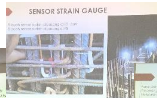
Pemasangan SHMS mulai dari tahap konstruksi pada Jembatan Musi IV dengan Sistem Extradoses (Gabungan Sistem Cable Stayed & Box Girder)
