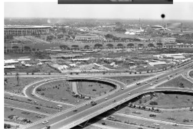
Ir. Sutami menggagas konstruksi prategang pada Jembatan Semanggi (1962)
