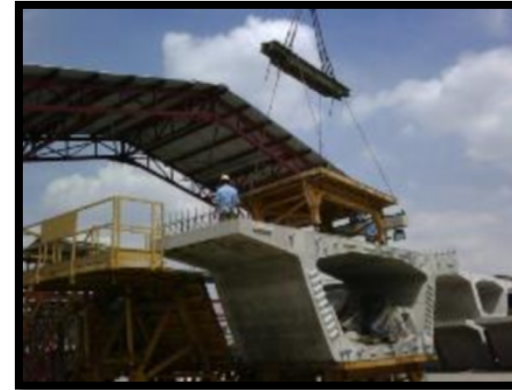
Sistem produksi Match Cast
