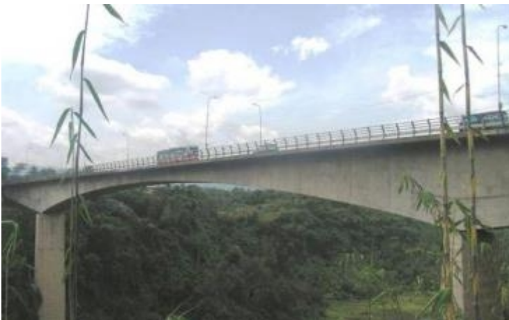
Struktur Prategang Metoda Kantilever pada Jembatan Rajamandala 1979
