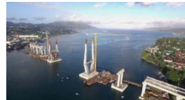
Merah Putih Bridge, Ambon (2015)
