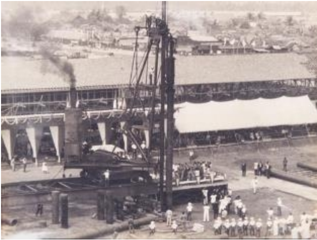
Tiang Pancang Pracetak pada Gedung Sarinah 1962
