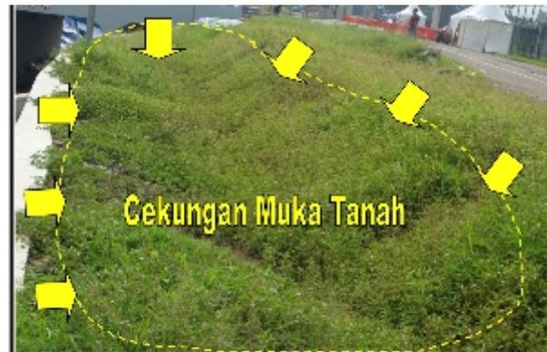
Foto 6. Kondisi cekungan permukaan tanah (top soil) pada belakang dinding panel beton RW
