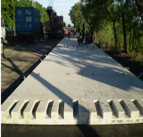
Jalan beton pracetak
