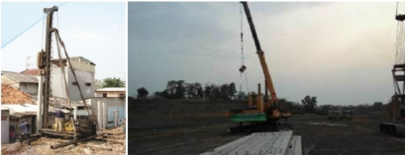
Alat pemasang : Drop Hammer dan HSPD
