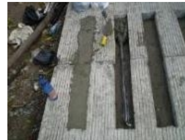
Grouting celah slab dan dasar, pemasangan sambungan dissipater
