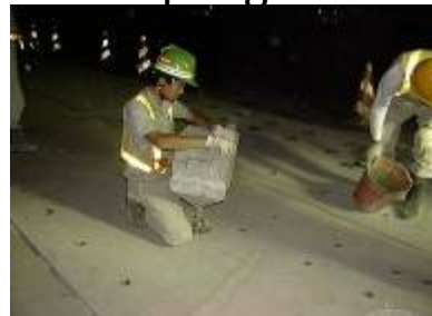
Grouting celah slab dan dasar, pemasangan sambungan dissipater
