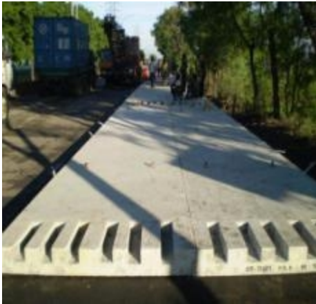
Jalan beton pracetak
