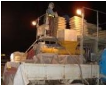
Grouting celah slab dan dasar, pemasangan sambungan dissipater
