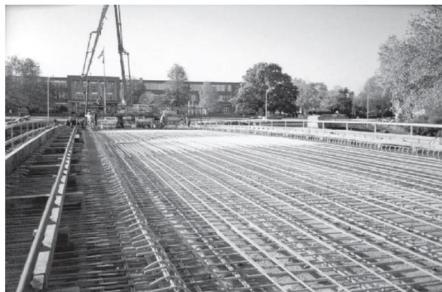
**Gambar C.1 – Konstruksi dek yang diperkuat dengan FRP di Lima, OH (Jembatan Pierce Street), pada 1999**
