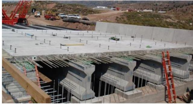
**Gambar C.4 – Panel dek Jembatan Emma Park dengan batang GFRP pada sisi atas dan bawah pelat**
