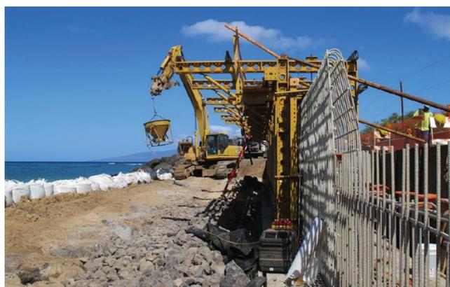
**Gambar C.6 – Konstruksi dinding laut dengan batang GFRP**
