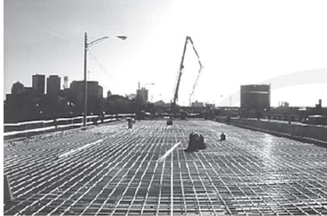
**Gambar C.2 – Batang GFRP digunakan untuk konstruksi dek di Dayton, OH, Jembatan Salem Avenue pada 1999**
