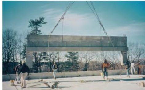
Gambar 5.3.1 – Contoh Rangka momen pracetak
