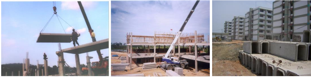
Gambar 10 Sistem Pracetak untuk Rumah Susun di Indonesia
