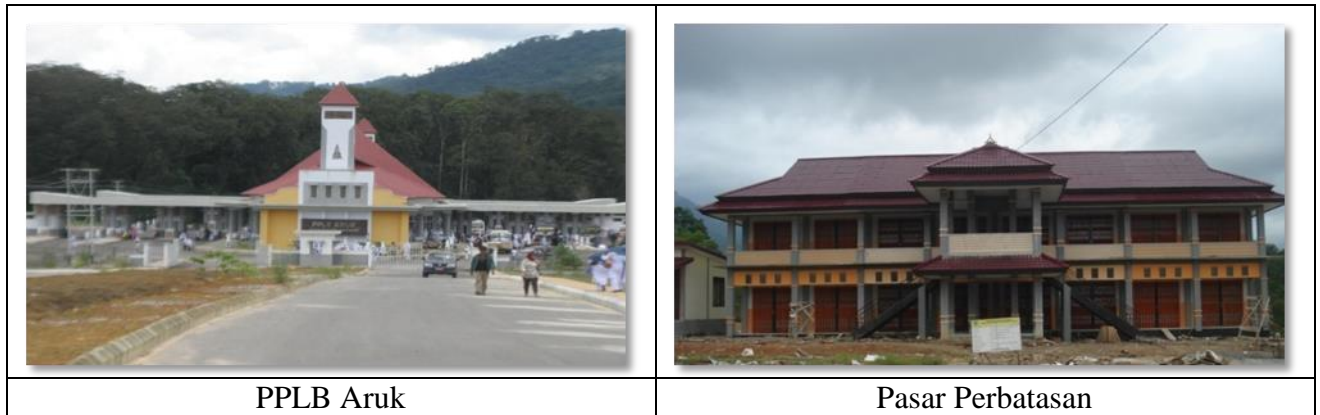
Gambar 4.4. Pembangunan PPLB Arusk yang sudah dilaksanakan (Sumber : BAPPEDA Kabupaten Sambas)
