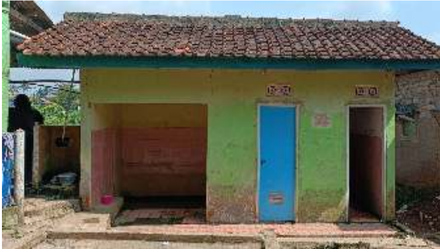
Foto 0%, Renovasi 1 Unit MCK di RW 01 Desa Cikancana
