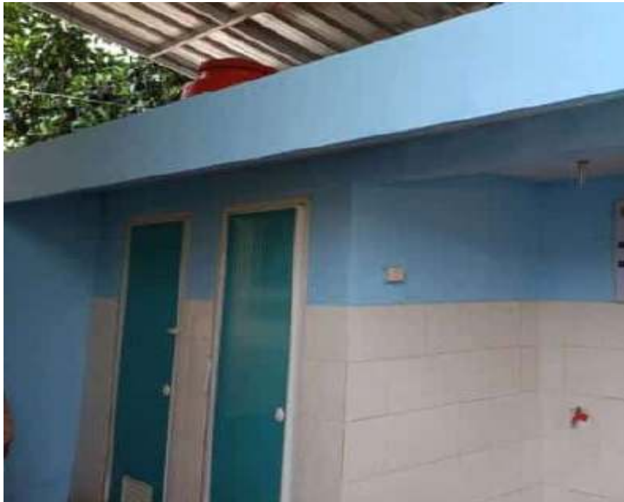
Foto 100%, Renovasi 1 Unit MCK di RW 01 Desa Cikancana
