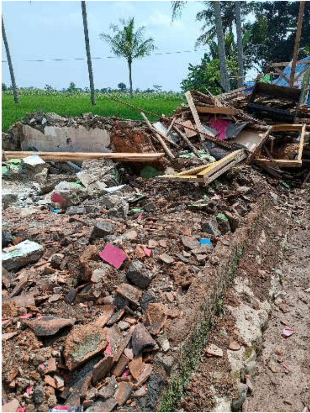
Foto 0%, MCK 2 Pintu di RW 01 Desa Cikancana
