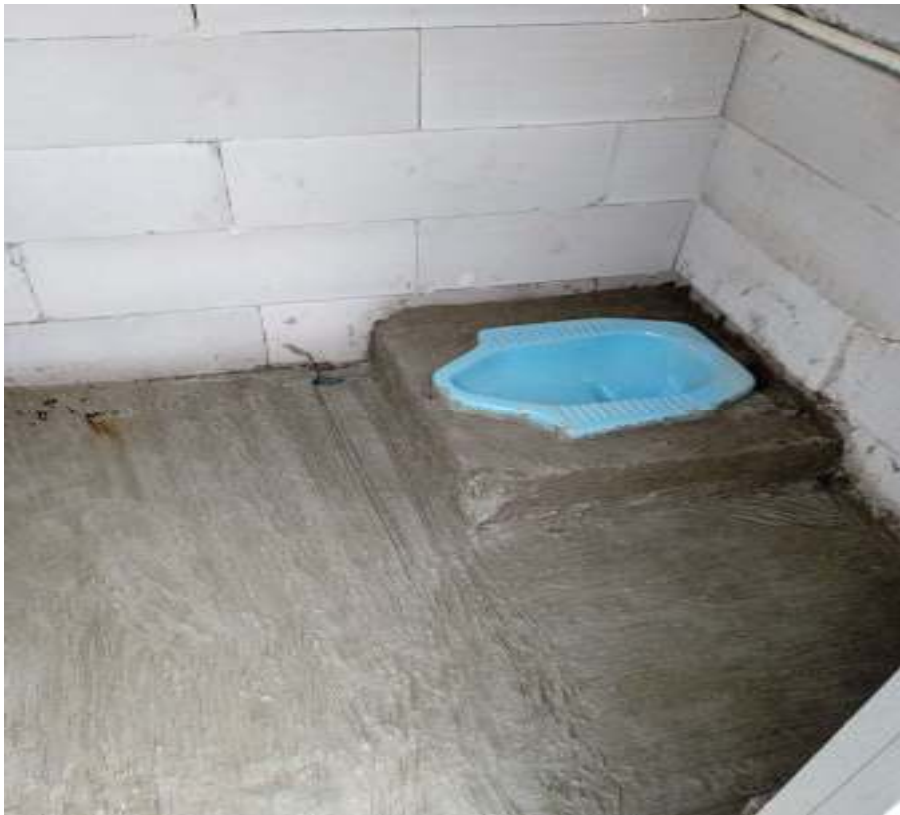
Foto 100%, MCK 2 Pintu di RW 01 Desa Cikancana
