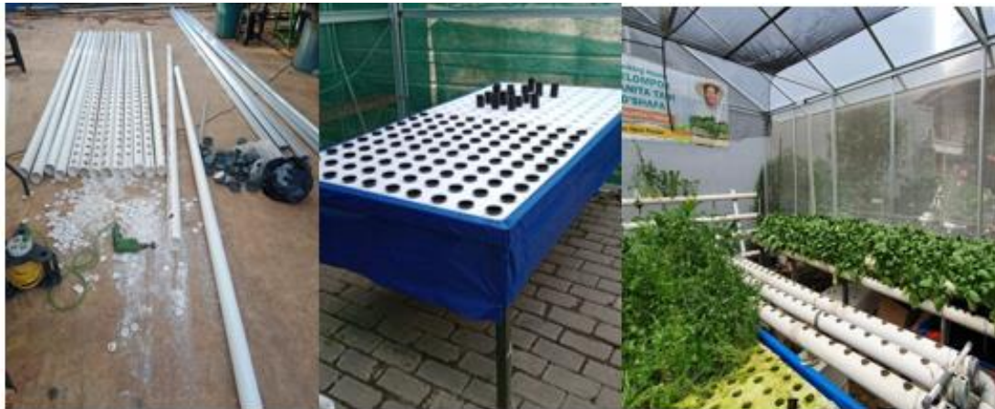
Gambar 4. Pembuatan Instalasi Hidroponik
