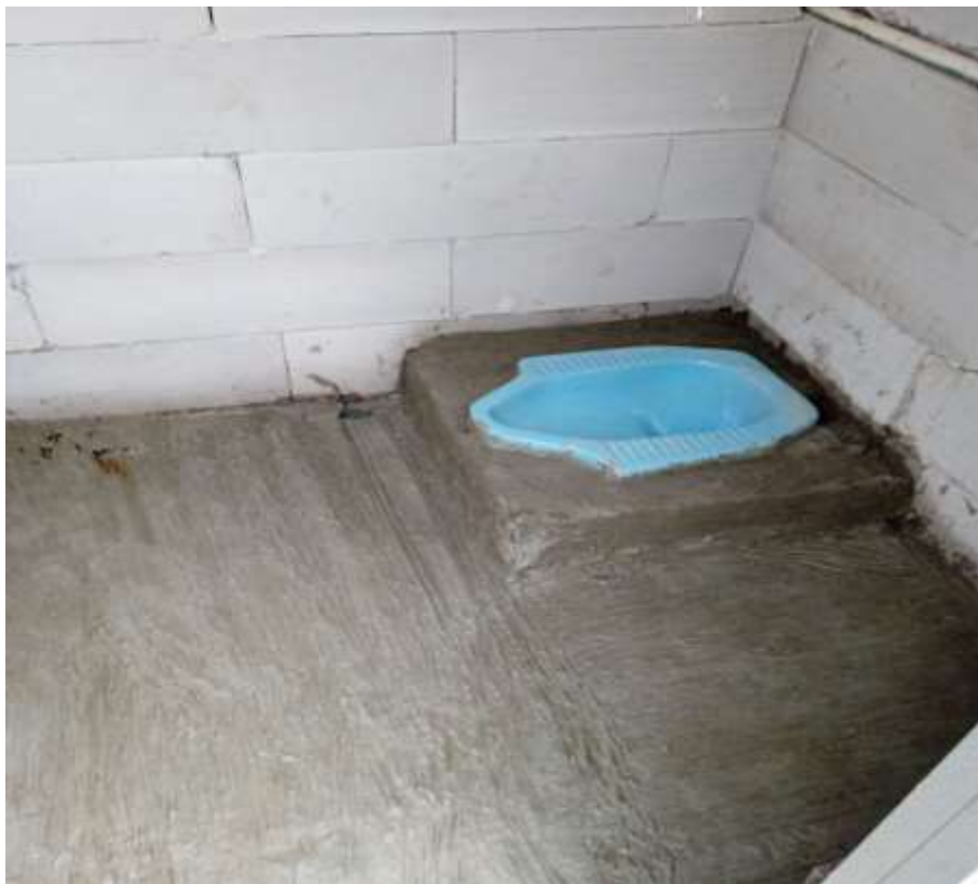
Foto 100%, MCK 2 Pintu di RW 01 Desa Cikancana
