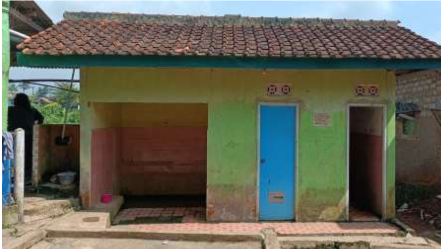
Foto 0%, Renovasi 1 Unit MCK di RW 01 Desa Cikancana
