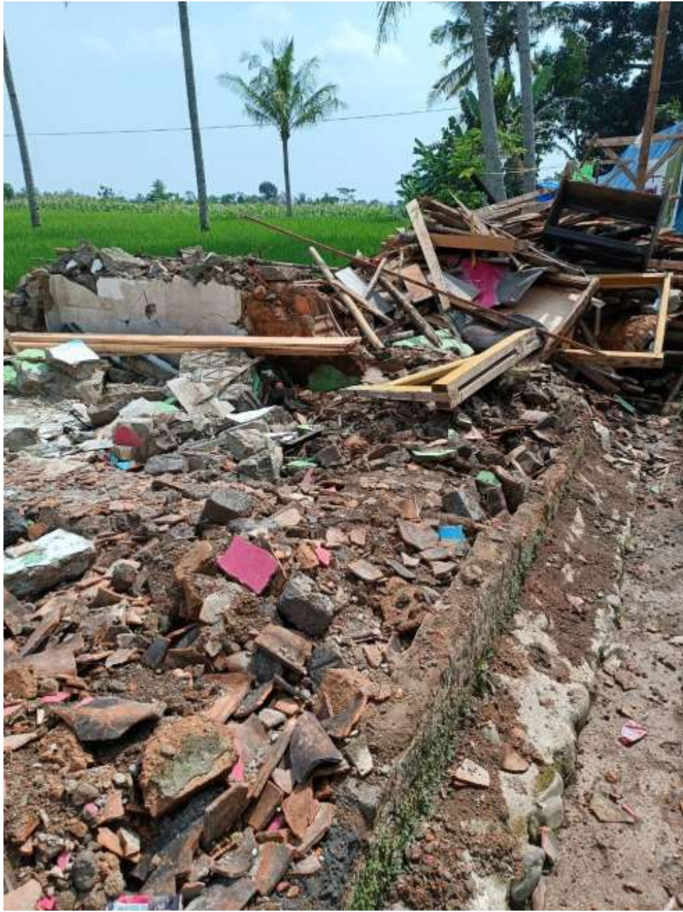
Foto 0%, MCK 2 Pintu di RW 01 Desa Cikancana
