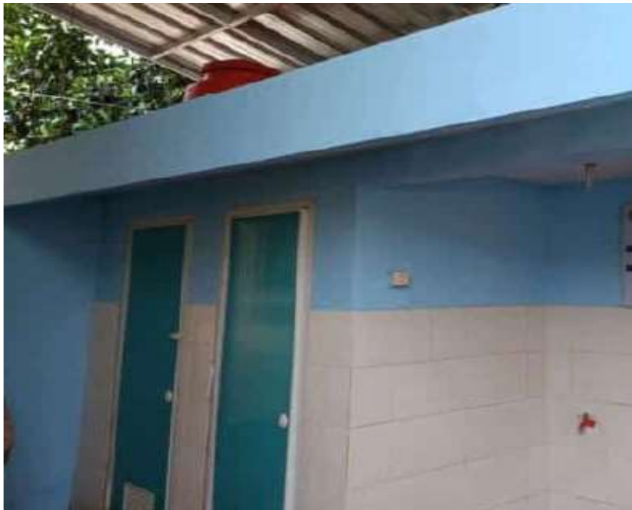
Foto 100%, Renovasi 1 Unit MCK di RW 01 Desa Cikancana
