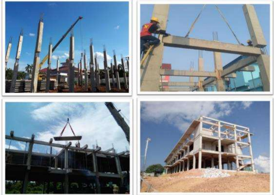
ERECTION KOMPONEN KOLOM, BALOK DAN PELAT BETON
