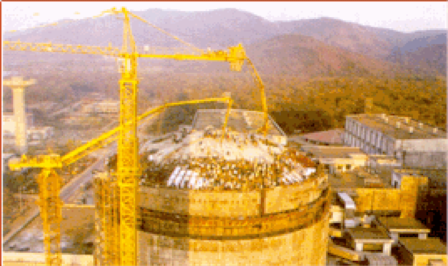
Last pour of IC dome under completion
