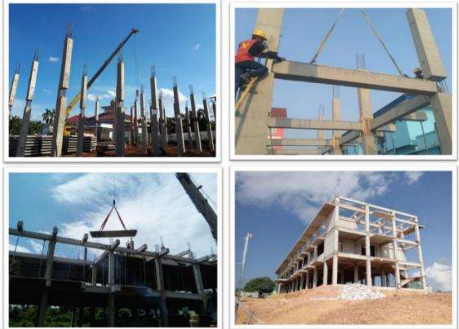
ERECTION KOMPONEN KOLOM, BALOK DAN PELAT BETON
