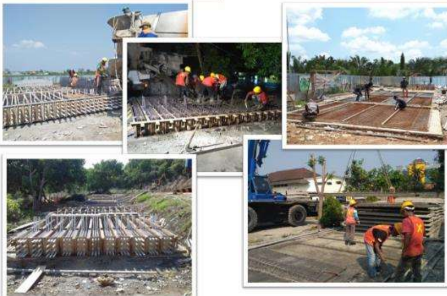
MOULDING KOMPONEN KOLOM, BALOK DAN PELAT BETON
