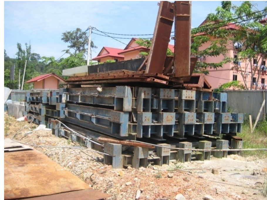
Cetakan pelat column slab dari bahan baja
