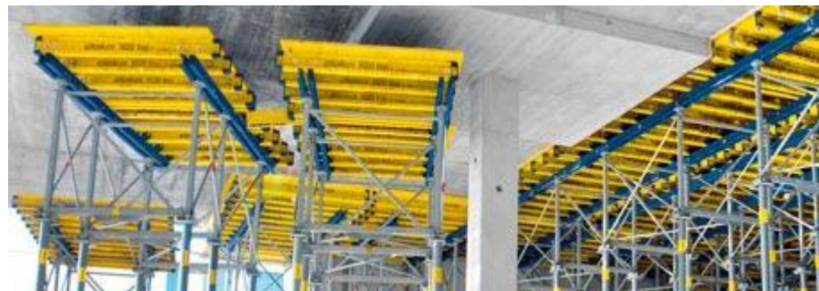
Sistem Perancah Bekisting
