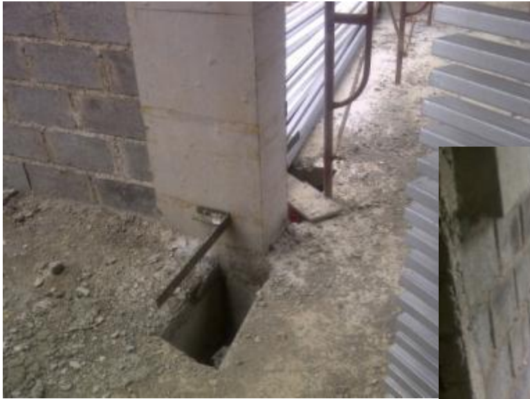
Persiapan pemasangan dinding dan pengaku pipa
