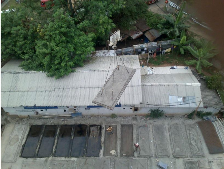
Erection Pelat
