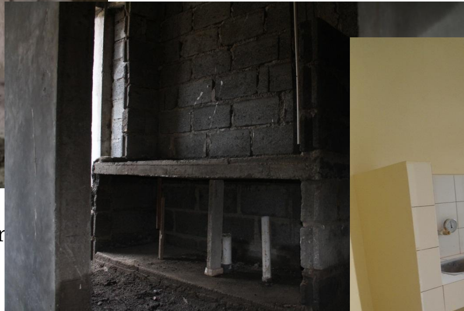
Pengecoran meja dapur dan pemasangan pipa air bersih
