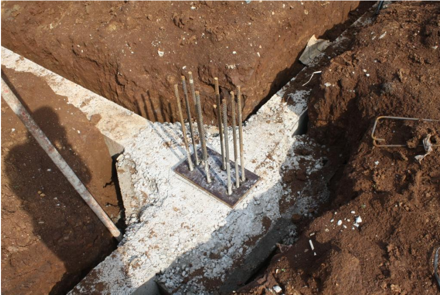
Pemasangan mal kolom
