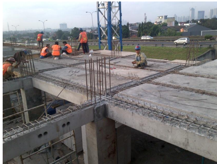
Grouting celah antar pelat
