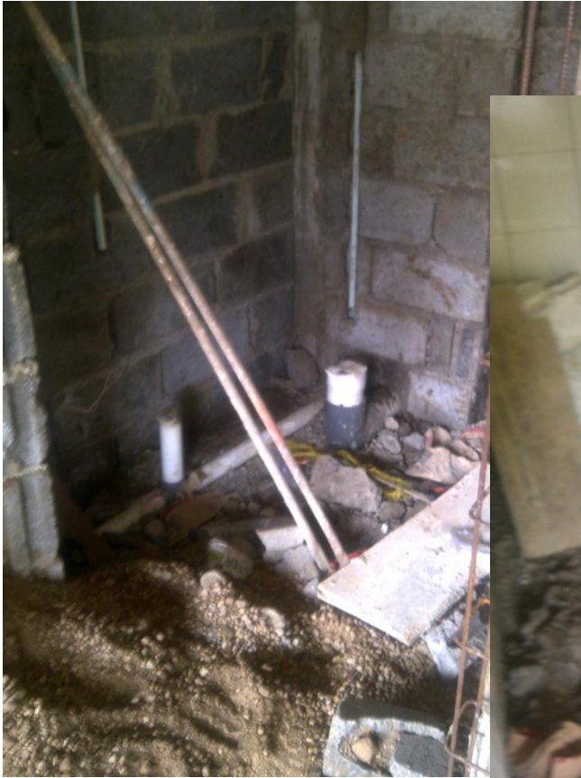
Pemasangan pipa ke dalam unit KM/WC
