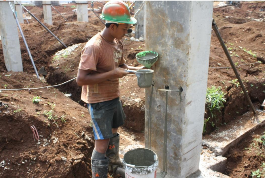
Grouting kolom dengan combextra
