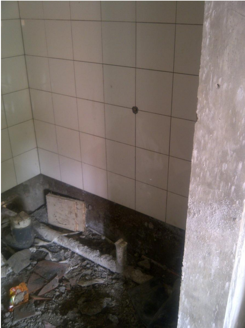
Pipa air bersih mesti pas di pertemuan pojok keramik dinding
