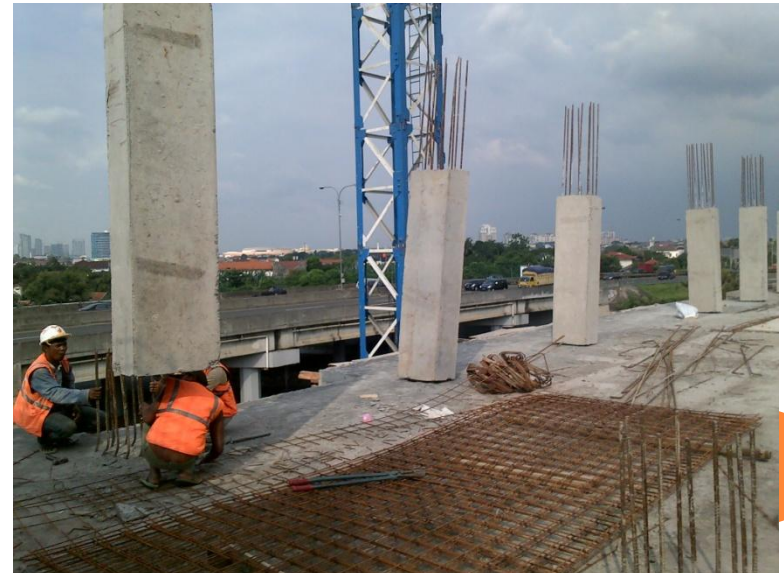
Erection kolom
