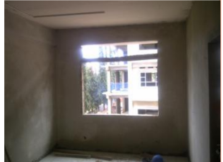
Pembuatan opening kusen dan lubang angin
