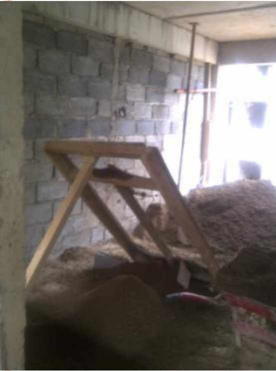
Pembuatan pasangan dinding
