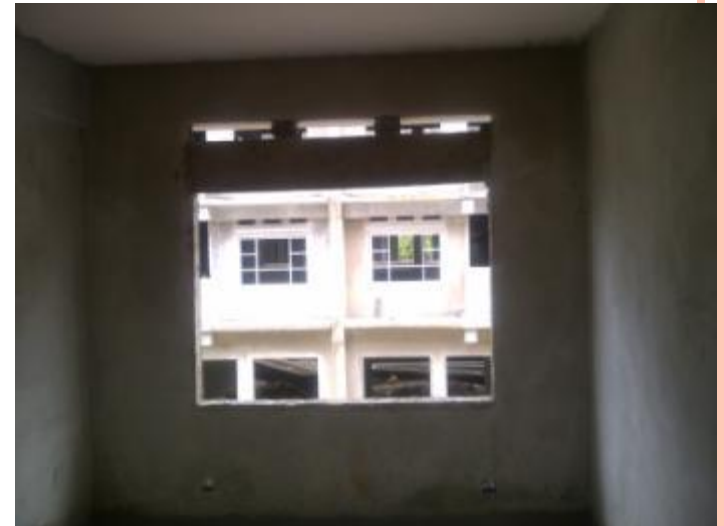
Pembuatan opening kusen dan lubang angin
