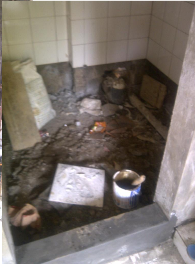
Pemasangan dinding keramik sampai batas waterproofing
