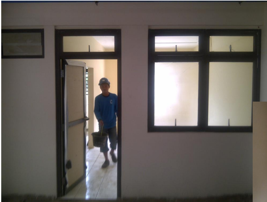
Pemasangan pintu dan jendela
